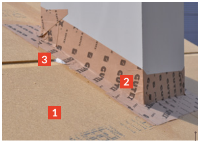
Penetración por la cubierta
